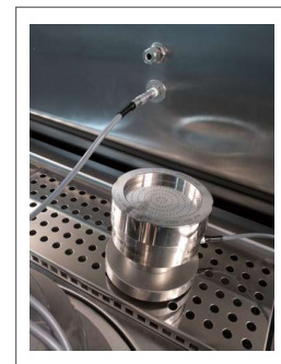
실제 Isolator 내에 설치되어 외부와 연결된 모습
